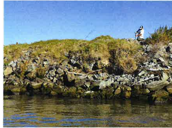
2 SITE 2 PHOTO N.T.S.
